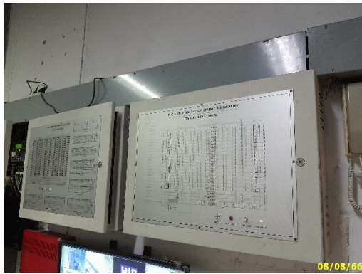
แผงควบคุมรวมระบบสัญญาณเตือนอัคคีภัย
